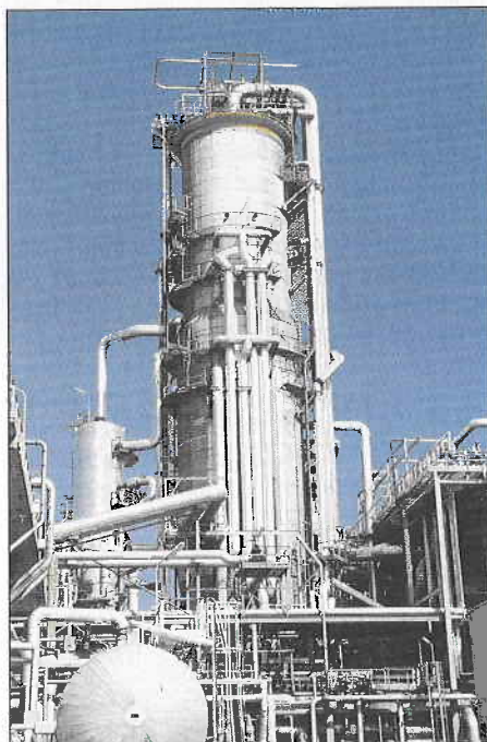
Abb. 4 Hauptkolonne der Rohöldestillation
