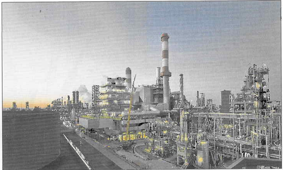
Abb. 12 Rauchgas Entschwefelungs- und Entstickungsanlage (SNOx)
